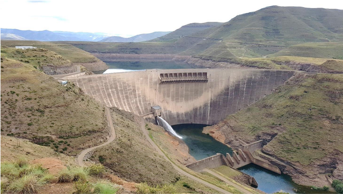
Bild 1: Katse Staumauer in Lesotho
